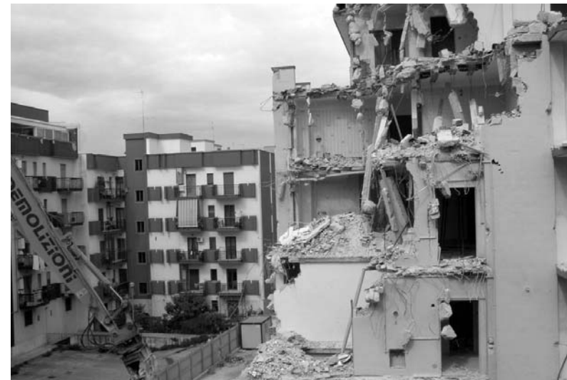
L'avvio della demolizione dell'edificio pericolante (foto Calvaresi)
